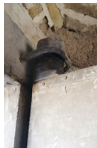
تصویر ۸. لولا، مکان از راست روستای بیش‌آقاج، روستای یدک، بقعه امامزاده ابراهیم (نگارندگان، ۱۴۰۳).
